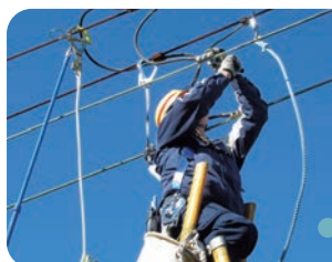
電車線の設備の取り替え作業中の様子
