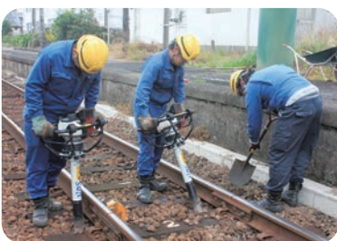
保線作業のひとつ、つき固めの作業の様子
